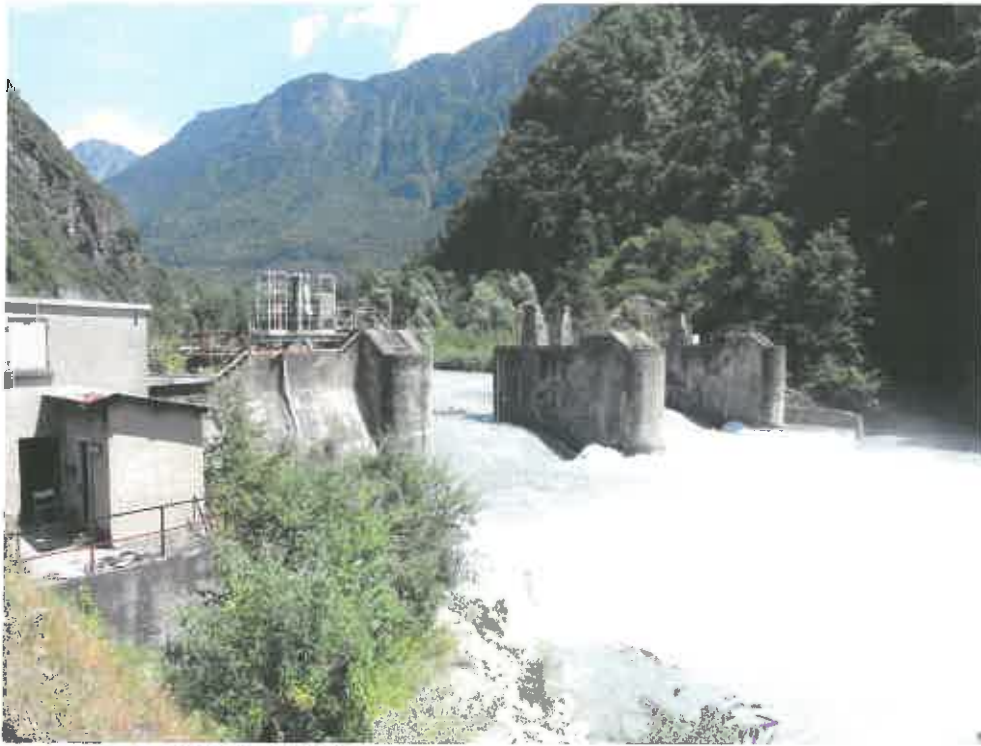
Le barrage sans ses vannes
