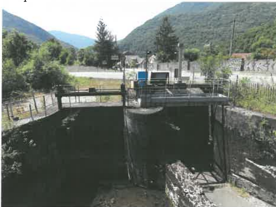
Le départ vers le canal d'amenée à l'usine
